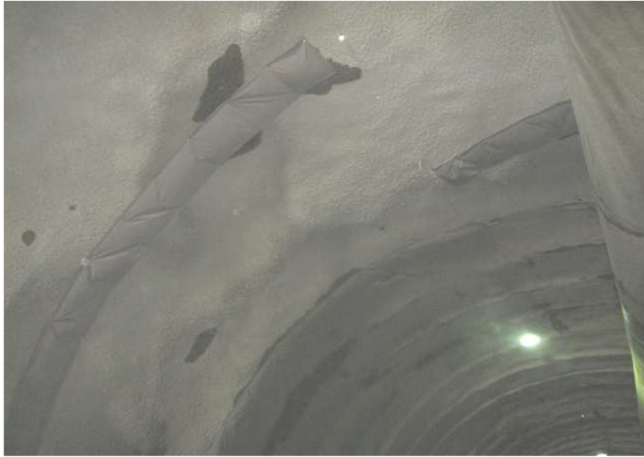
STA 2+475 ~ 2+822 방수공 현황
