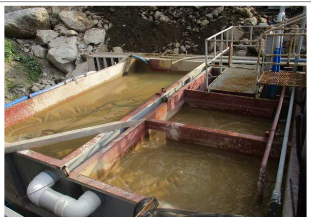
오·폐수 처리시설 전경
