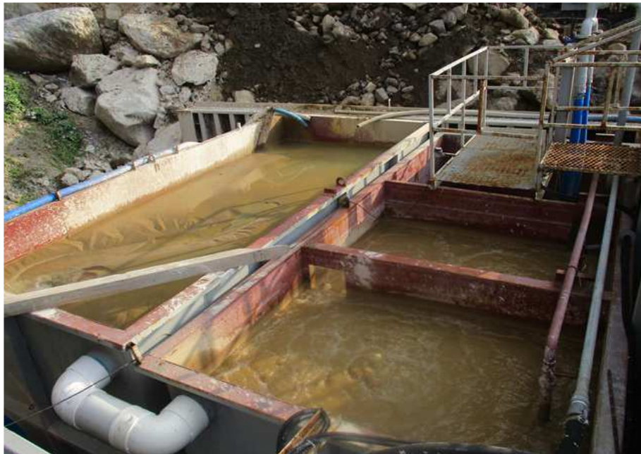
오·폐수 처리시설 전경
