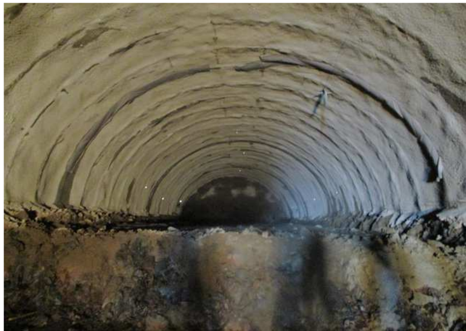
STA 2+475 ~ 2+822 터널 굴착 현황
