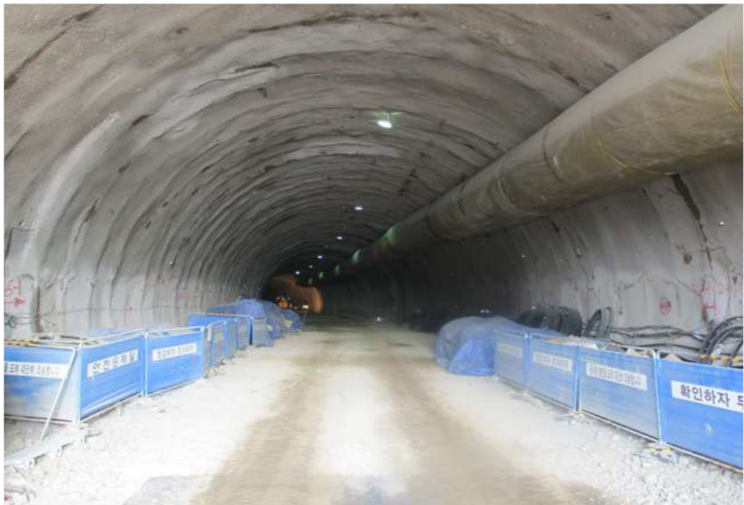
북면터널 시점부 내부 전경
