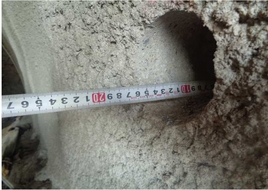
STA 2+475 ~ 2+822 터널 지보공 현황
