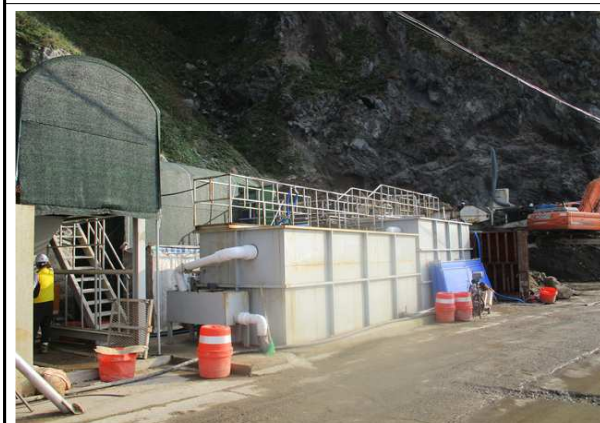
오·폐수 처리시설 전경
