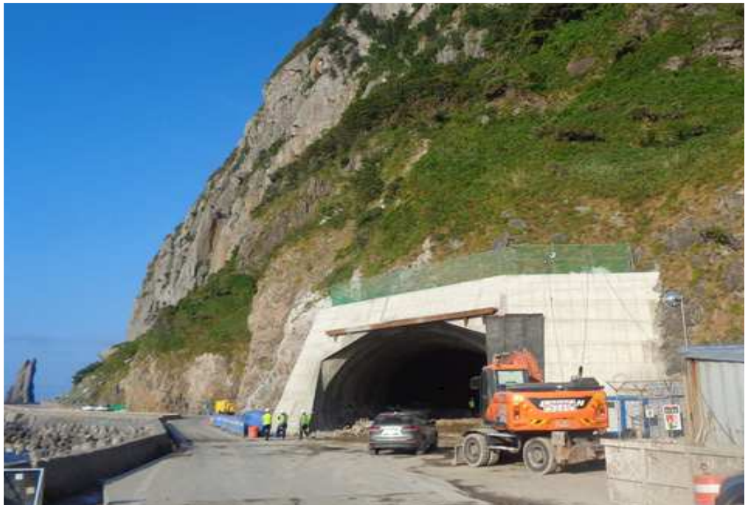
북면터널 시점부 갱구 전경
