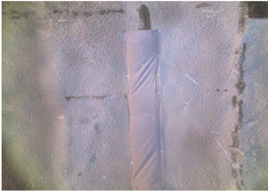
STA 2+475 ~ 2+822 방수공 현황
