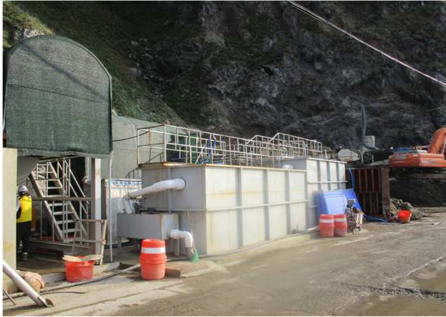
오·폐수 처리시설 전경
