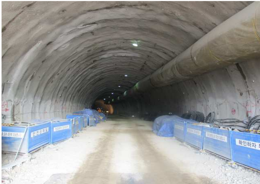
북면터널 시점부 내부 전경
