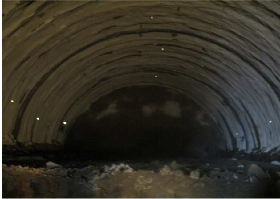
STA 2+475 ~ 2+822 터널 계측 현황
