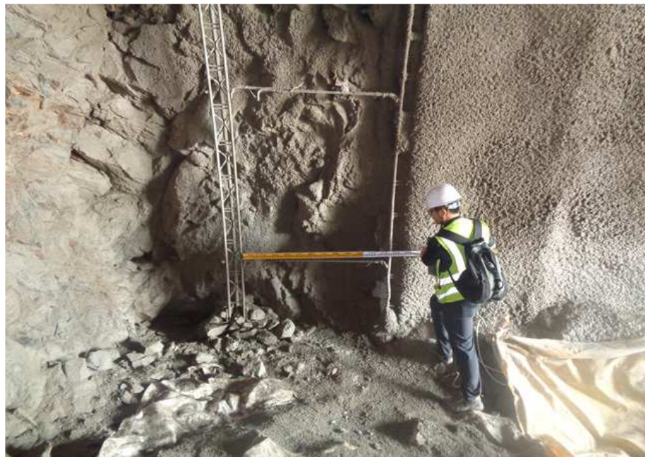
STA 2+475 ~ 2+822 터널 지보공 현황
