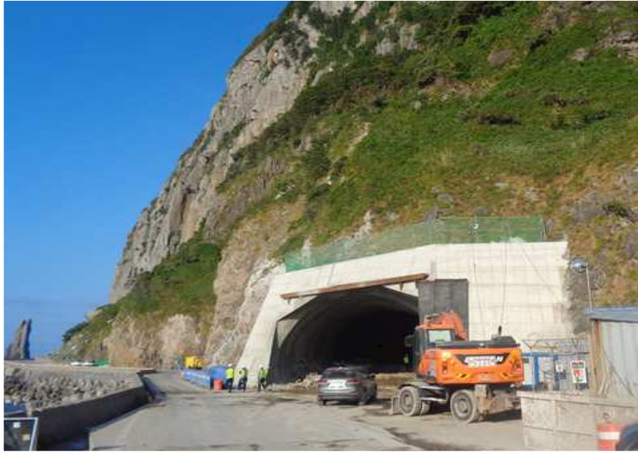
북면터널 시점부 갱구 전경
