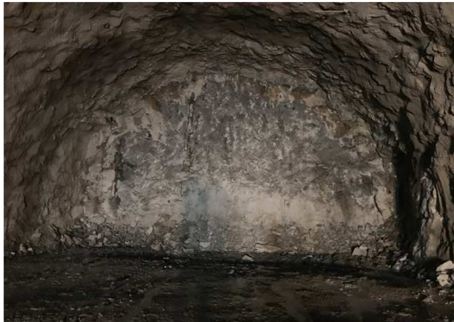
STA 2+475 ~ 2+822 터널 굴착 현황
