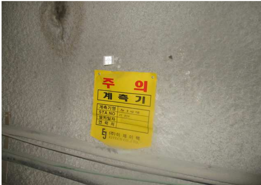
STA 2+475 ~ 2+822 터널 계측 현황
