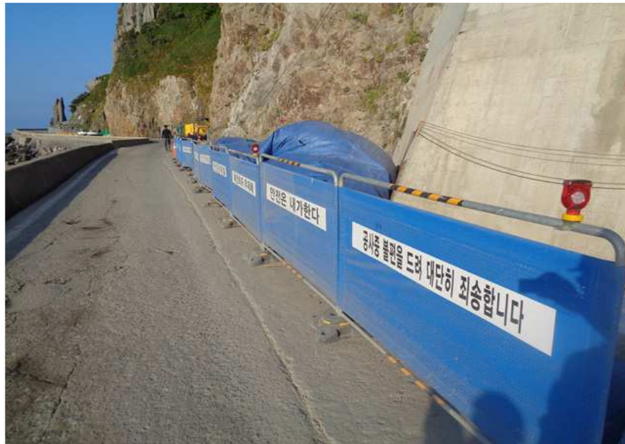
도로 안전펜스 전경
