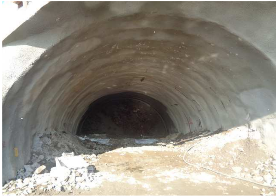
STA 2+475 ~ 2+822 터널 굴착 현황
